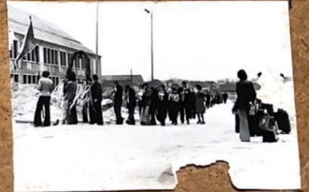
Das Baugelände ist erreicht
